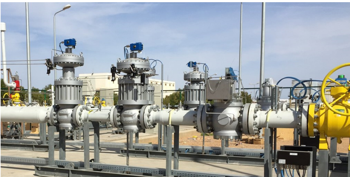
Monitor Reflux 819/FO/DB + monitor Reflux 819/DB + válvula de cierre rápido HBC 975 Skid de gas combustible para turbinas de gas en EMEA
